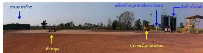
รูปที่ 2-4 แผนผังกระบวนการทดสอบหลุม และตัวอย่างการจัดวางอุปกรณ์เพื่อการทดสอบหลุม (Well Testing) ของโครงการฯ
