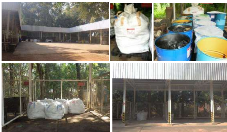
รูปที่ 3-12 พื้นที่จัดเก็บของเสีย ที่มีคั่นกันล้อมรอบ และตัวอย่างภาชนะจัดเก็บของเสียอันตราย ประเภทต่างๆ
