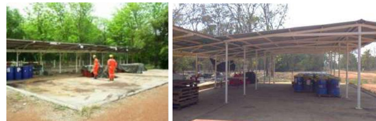
รูปที่ 3-11 ลักษณะพื้นที่จัดเก็บกากตะกอนปนเปื้อนน้ำมันจากการทำความสะอาดท่อขนส่งน้ำมัน ภายในสถานีผลิตลานกระบือ
